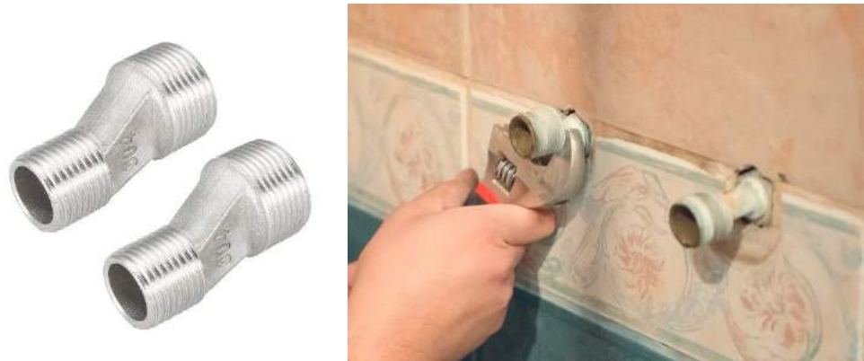
Figura 1 Desenroscado de brazos oscilantes.
