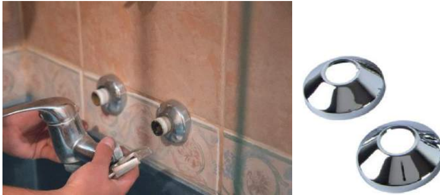
Figura 4 Liberación del monomando y desenroscado de campanas.
