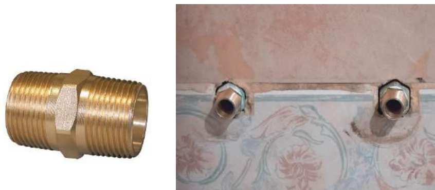
Figura 6 Enroscado de nipples. (aplicar previamente teflón).
