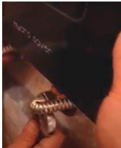
Figura 5 Ajuste flexibles a las salidas de agua.
